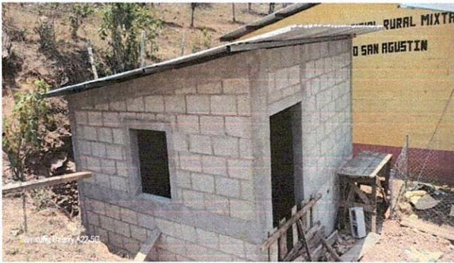
Foto 1: Cocina parte lateral en proceso de ejecución.
