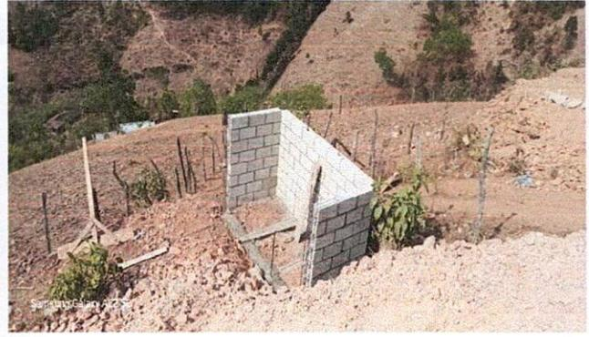
Foto 2: Sanitario parte frontal y lateral en ejecución.
